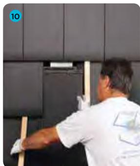
10 Soulever la cale de gauche pour créer un jeu. Faire glisser la tuile de remplacement après avoir cassé les tenons et réaliser 2 trous sur sa face apparente
