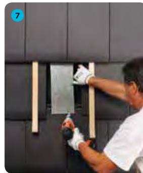
7 Fixer la platine en partie basse dans les trous de préperçage de la tuile inférieure
