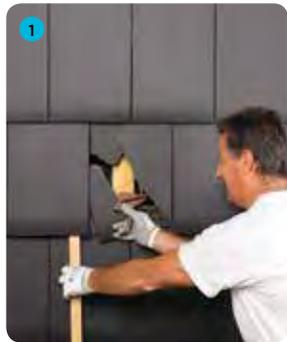
1 Placer une cale sous la tuile gauche voisine de la tuile cassée pour créer un jeu et faciliter le retrait des morceaux
