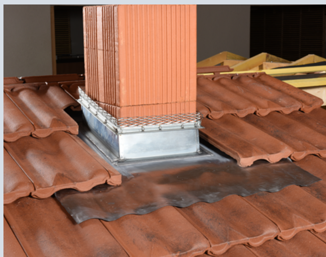
6- Repositionner les tuiles périphériques.
