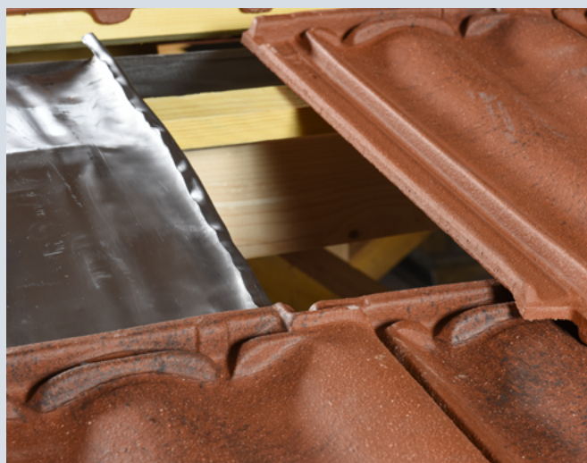
4- Nous préconisons de replier les bords extérieurs de la table.
