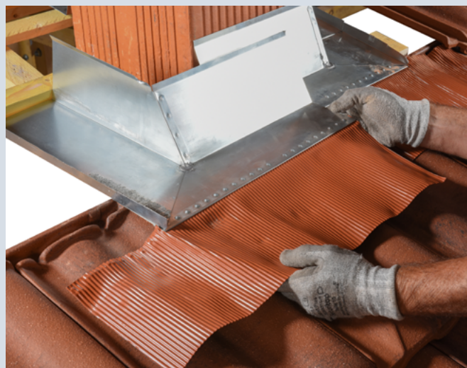
2- Mettre en place les 4 pièces de l'abergement et les resserrer autour du boisseau. Vérifier que les pièces arrière recouvrent celles avant d'au moins 30 mm.
