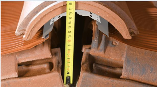
1- Prendre les mesures du complexe closoir-faitière et déterminer les hauteurs de la lisse de rehausse et du bois de fourrure pour qu'a posteriori la faitière ne repose pas sur le closoir.
