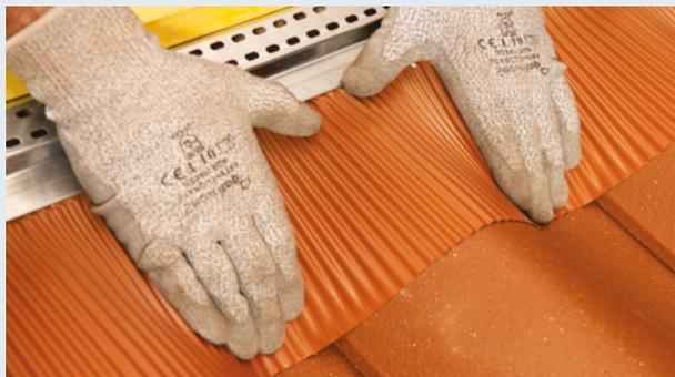
4- Maroufler les bavettes du closoir sur les tuiles. Positionner et fixer les faitières de manière à ce que le recouvrement soit opposé aux vents dominants. Appliquer de l'huile de patine sur les bavettes plomb, pour optimiser la résistance à la corrosion. Recouvrir le closoir rigide Shark+ avec les tuiles faitières ou les arêtiers, compatibles avec les petits éléments de couverture utilisés en plain carré.
