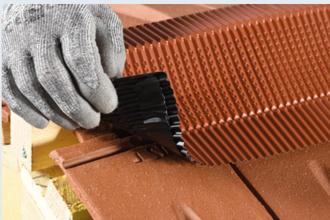
3- Retirer la bande de protection butyle à l'avancement, presser et maroufler les bavettes sur les tuiles.
