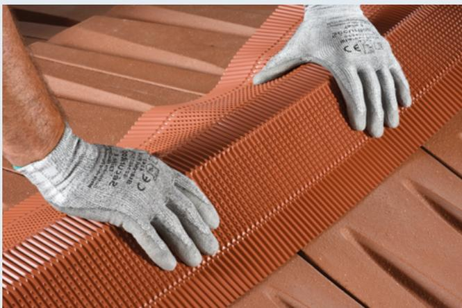
1- Après avoir positionné la lisse de rehausse dans l'axe du faîtage, dérouler et positionner le cloisir sur celle-ci.
