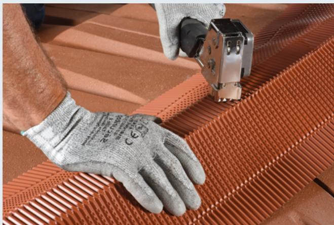
2- Fixer le cloisir au niveau de la bande de renforcement à l'aide d'agrafes ou de pointes.
