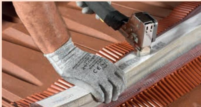
2 - Fixer le closioir au niveau de la bande de renforcement à l'aide d'agrafes ou de pointes.
