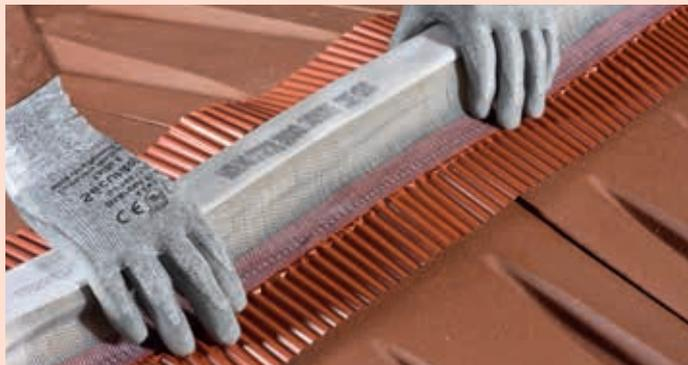
1 - Après avoir positionné la lisse de rehausse dans l'axe du faîtage, dérouler et positionner le closioir sur celle-ci.
