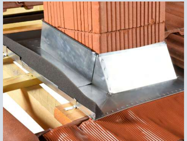
4- Après avoir soudés les 4 éléments, coller le joint mousse sur le pourtour de l'abergement.
