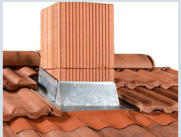
6- Repositionner les tuiles périphériques avec un espace d'écoulement des eaux pluviales supérieur à 8 cm. Finir l'ouvrage en tirant un joint mastic entre le boisseau et l'abergement.
