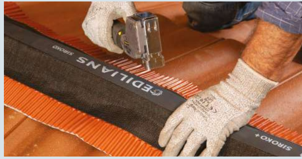
2- Fixer le closoir au niveau de la bande de renforcement à l'aide d'agrafes ou de pointes.
