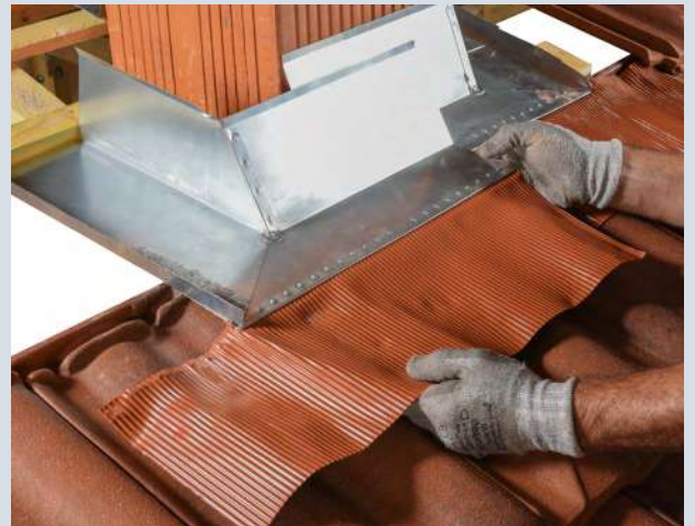
2- Mettre en place les 4 pièces de l'abergement et les resserrer autour du boisseau. Vérifier que les pièces arrière recouvrent celles avant d'au moins 30 mm.
