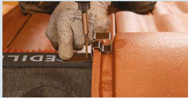
4- Positionner et fixer les fainières de manière à ce que les recouvrements soient opposés aux vents dominants.
