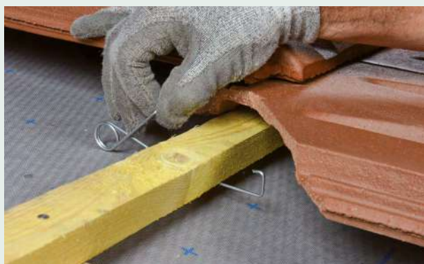
1- Crochet à harponner en sous face du liteau.
