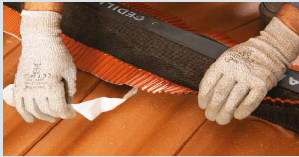
3- Retirer la bande de protection butyle à l'avancement, presser et maroufler les bavettes sur les tuiles.
