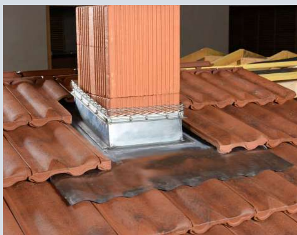
6- Repositionner les tuiles périphériques.
