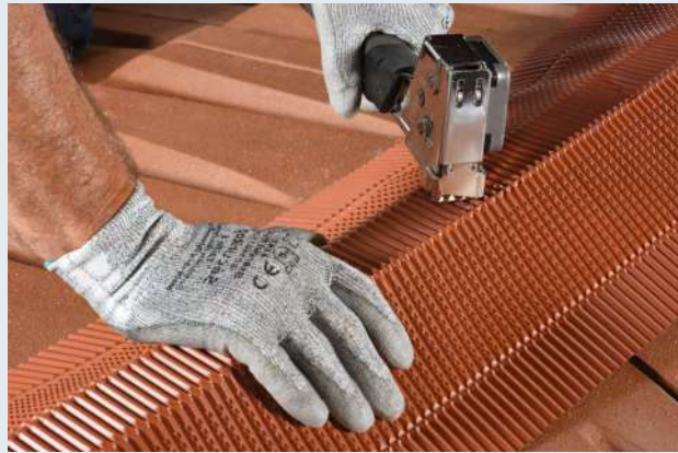
2- Fixer le closoir au niveau de la bande de renforcement à l'aide d'agrafes ou de pointes.
