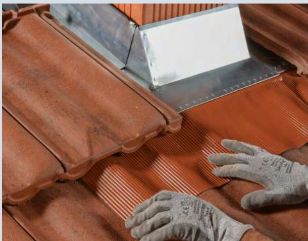
5- Maroufler la bavette plomb sur la première rangée de tuiles.
