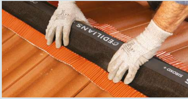
1- Après avoir positionné la lisse de rehausse dans l'axe du faitage, dérouler et positionner le closoir sur celle-ci.
