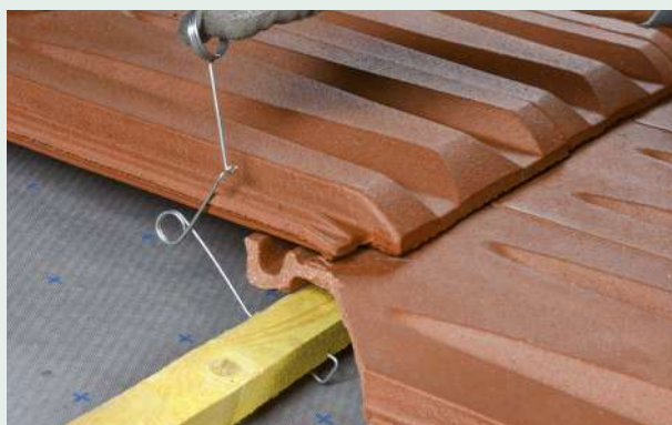
2- Partie supérieure à reprendre avec l'outil fourni pour plus de facilité et rapidité.
