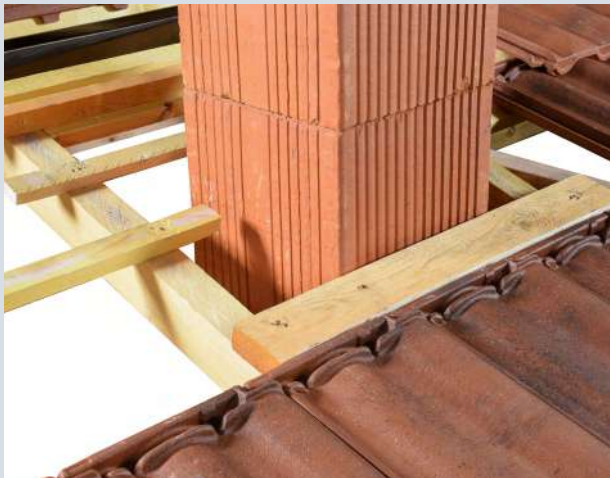
1- Retirer les tuiles autour du boisseau ou de la souche de cheminée.
