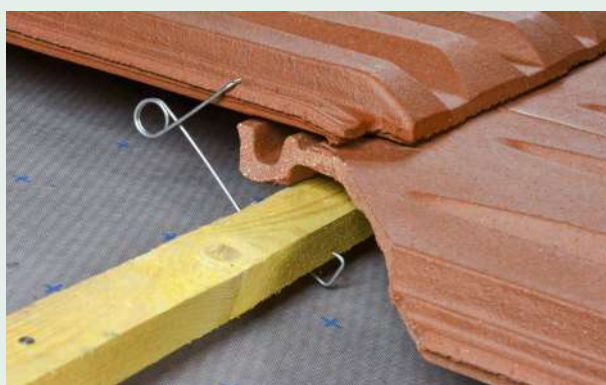
4- Déposer le crochet dans l'emboîtement de la tuile pour assurer la fixation.
