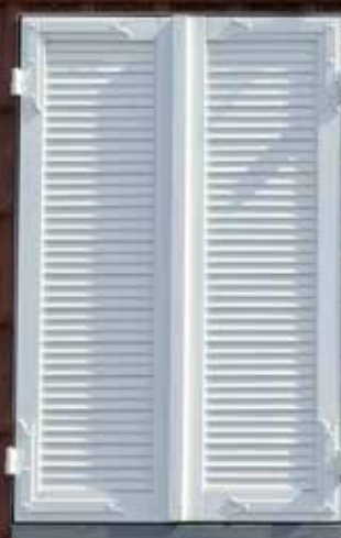
LOSANGEE Huguenot Architecte : Edouard François Crédit photo © Paul Raftery
